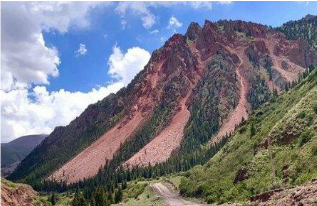
Рисунок 2 - Оползень на вершине Токсон-Теке
