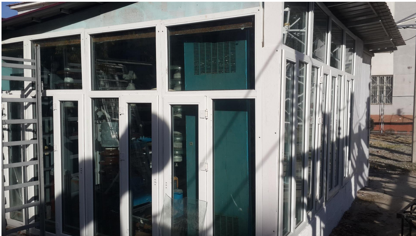
Учебный полигон 35/10 кВ «Политех»
