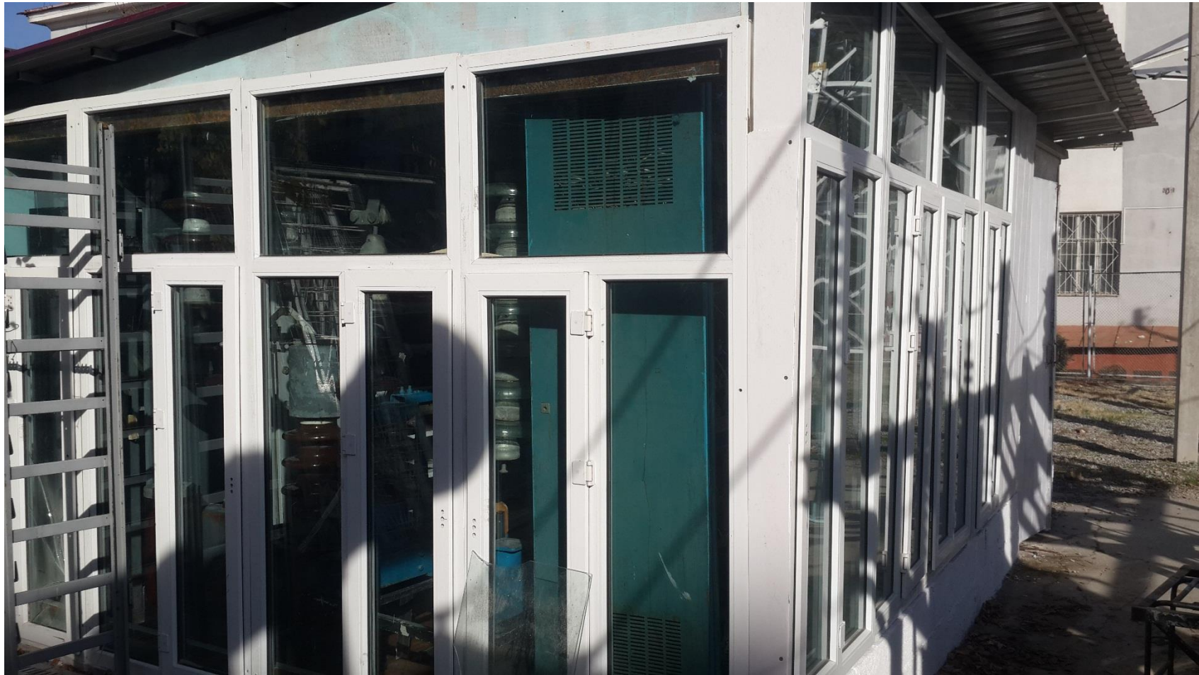
Учебный полигон 35/10 кВ «Политех»
