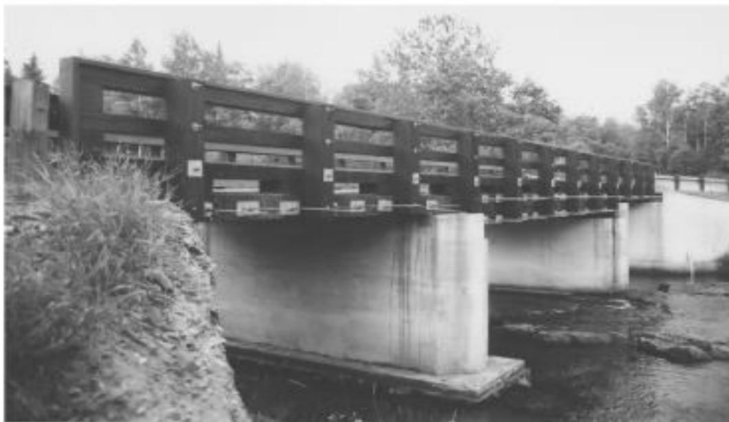
Рис. 1. Общий вид моста с предварительно напряженной многослойной древесиной. Мост Большого Эрика на р. Гурон (Big Eric's Bridge, Huron river) [7]
