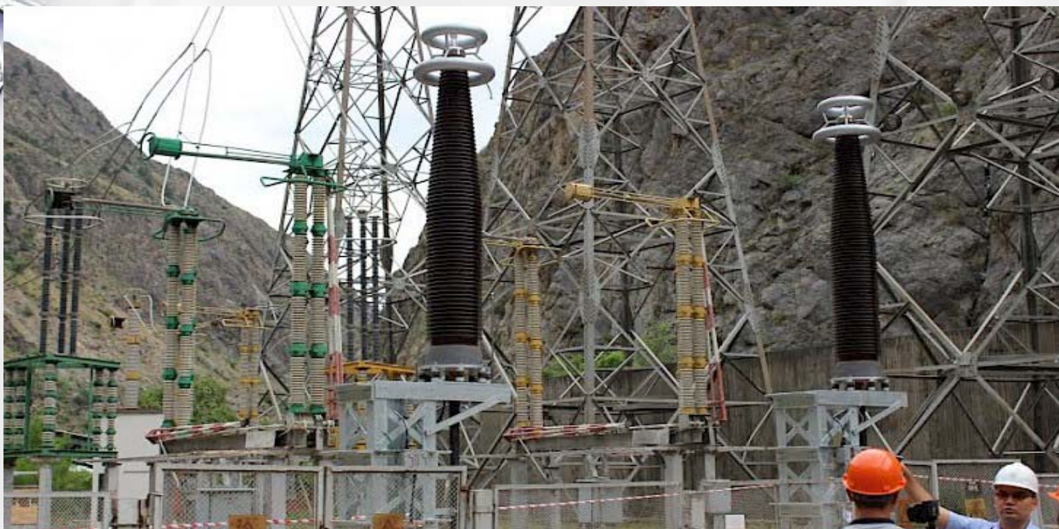
Рис.6.1.1. ОРУ-500кв. Токтогульской ГЭС
