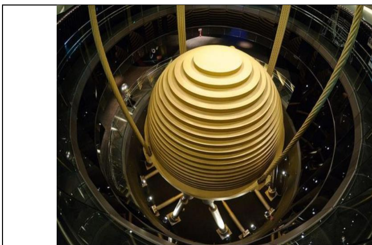
Рисунок 3 - Инерционный демпфер на высотном здании Тайбэй
