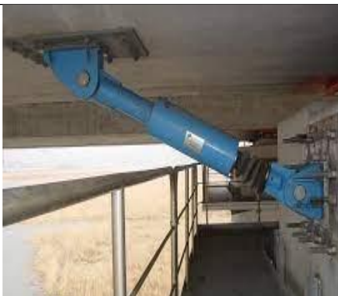
Рисунок 2 - Сейсмический демпфер
