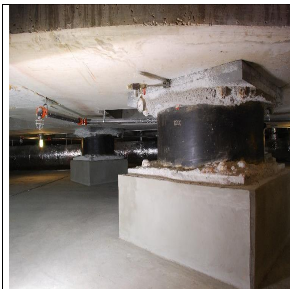
Рисунок 1 - Сейсмическая изоляция основания
