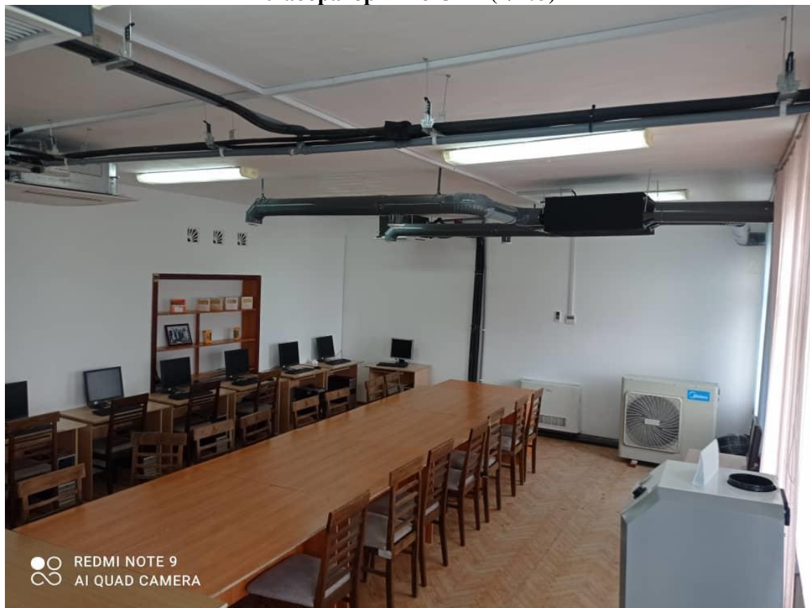
Лабораторная установка «Энергосберегающая установка с рекуператором». Лабораторная установка «Тепловой насос».
