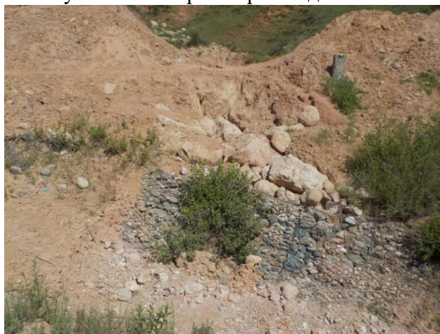
Рисунок 4. Промоина дамбы отстойника
