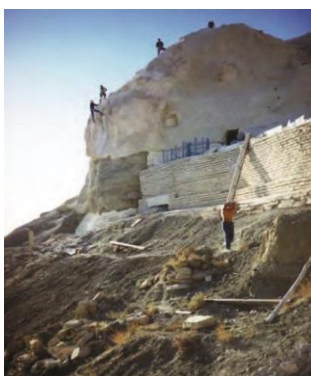
Вид во время реставрации
