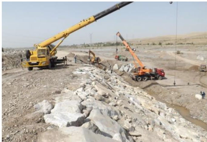
Фотодокумент. 4. Русло и берег реки Кара-Ункур проведение ремонтно-восстановительных берего-укрепительных работ в Джалал-Абадской
