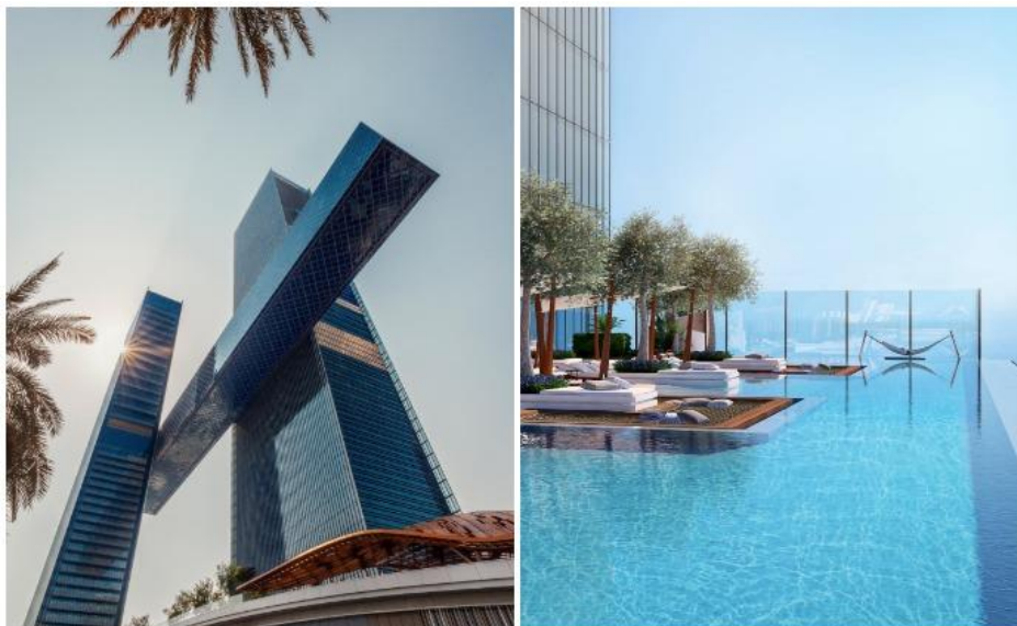
Рис. 3. Самая длинная консоль в мире, зависшая на высоте 100 метров, – уникальнейшее инженерное чудо, от проектировщиков и строителей (One Za'abeel, Дубай 2024).
