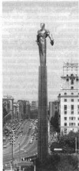
Рис. 123. Памятник Ю. А. Гагарину изготовлен из титанового сплава, не подвергающегося коррозии
