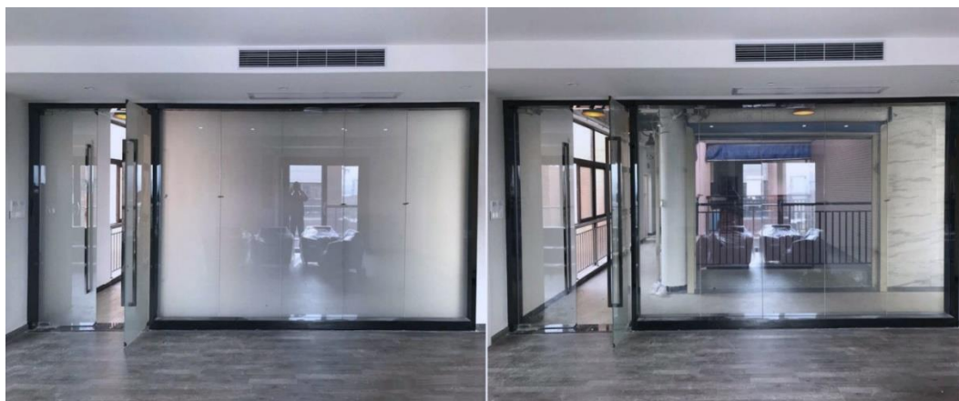
Рис. 8. Энергопотребляемое стекло с регулированием мощности
