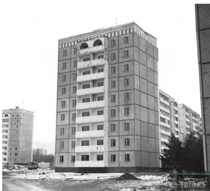
Рисунок 2 - Панельный дом 1987г. г. Фрунзе
